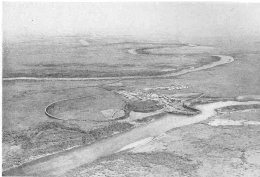
Rincón del Bonete. Emplazamiento general. Iniciación de los trabajos en la margen derecha.
